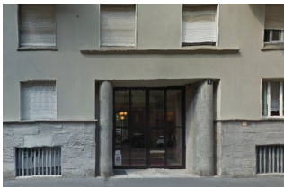
CONDOMINI VIA BANDELLI 6 e 8 MILANO
